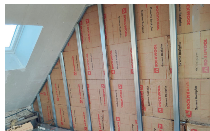
Isolation des rampants par l'intérieur
