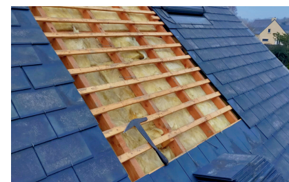
Isolation sous toiture par l'extérieur
