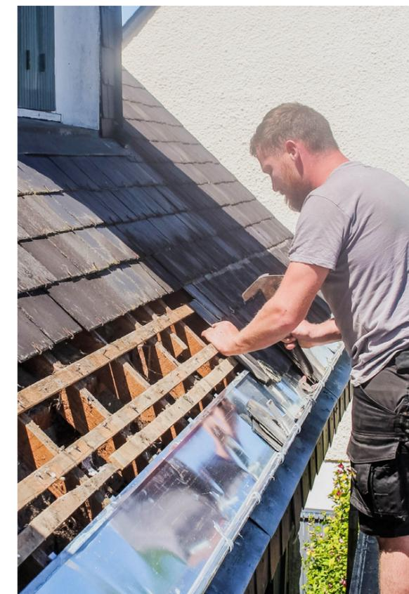
**L**'entretien de toiture, les réparations et l'étanchéité des toits-terrasses font aussi partie des services proposés par **ADRIEN TOURAINE** : remplacement d'ardoises, fixation de gouttières, nettoyage, démoussage, détection et réparation de fuites, y compris sur toitures bitumées.
