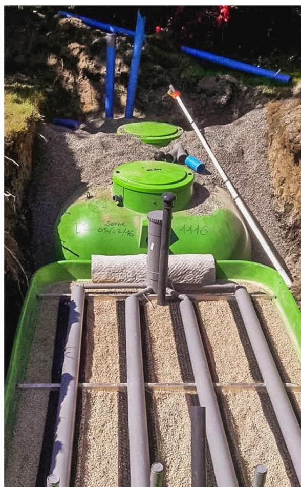
En ce qui concerne l'assainissement individuel et de raccordement tout à l'égout, la SARL AO2T propose plusieurs solutions : Filtre compact, filtre à sable, micro-station. Sachant que l'entreprise préconise les filtres compact pour sa faible emprise au sol et son fonctionnement sans électricité ni élément électromécanique ce qui lui confère une grande fiabilité.
