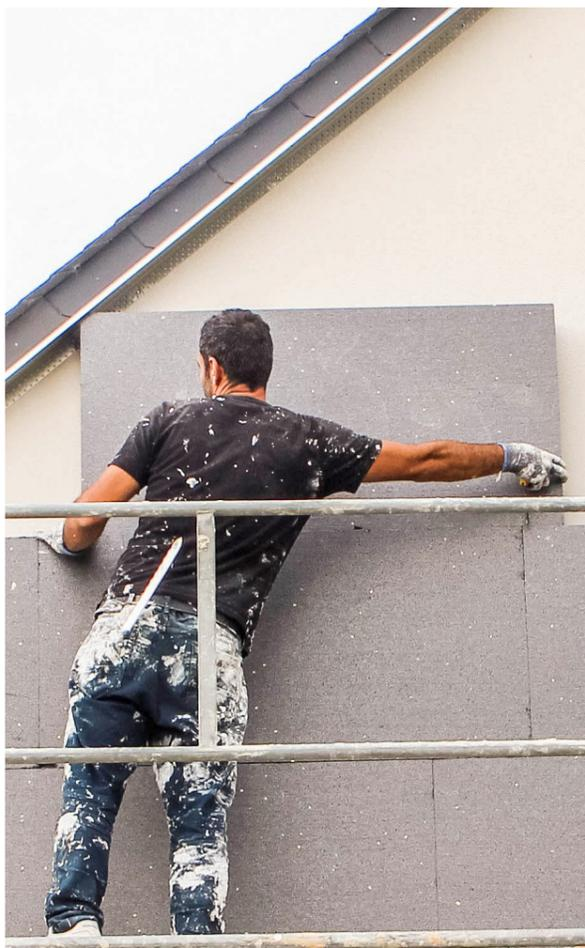
**N**otamment en Isolation Thermique par l'extérieur. IMR Bâtiment assure elle-même tous les travaux, Citons la pose des rails et profilés d'arrêt, la fixation des panneaux isolants par chevillage, le remplissage des vides, le traitement des points singuliers, l'application de couche armée, lés de fibre de verre et enduit de finition.
