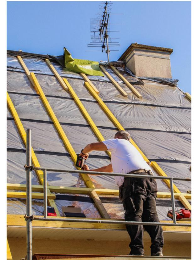
Étant donné qu'il n'était pas question de démolir la décoration intérieure, **ARTI HOME** a conseillé une intervention par l'extérieur, plus avantageuse à long terme. L'ancienne toiture a alors été remplacée, permettant l'installation d'un isolant mince double épaisseur, recouvert d'ardoises naturelles de 1ère catégorie, assurant ainsi performance et durabilité.
