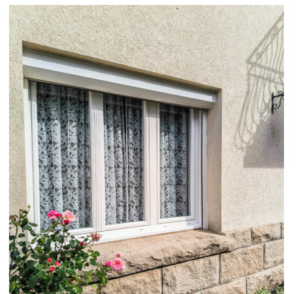
Fenêtre en sous-sol !
