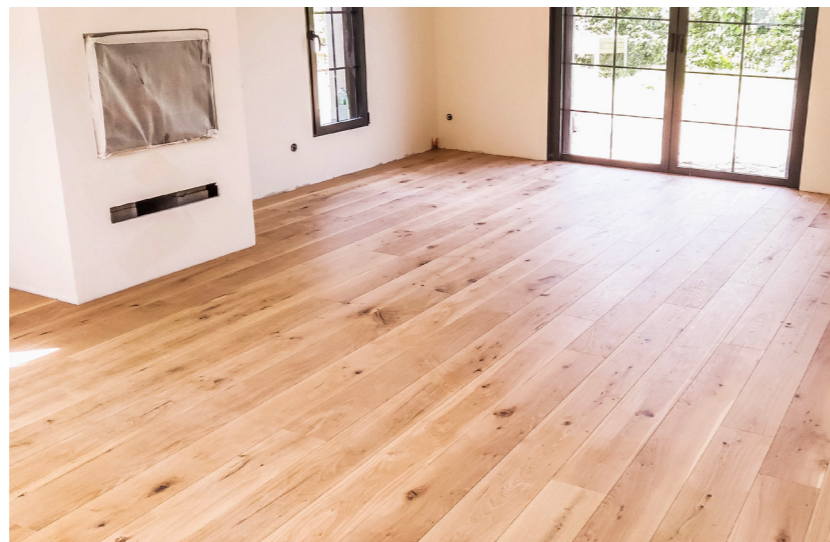
Pose d'un parquet collé !
