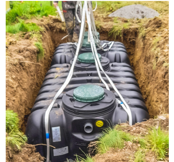
Pose d'un filtre compact !
