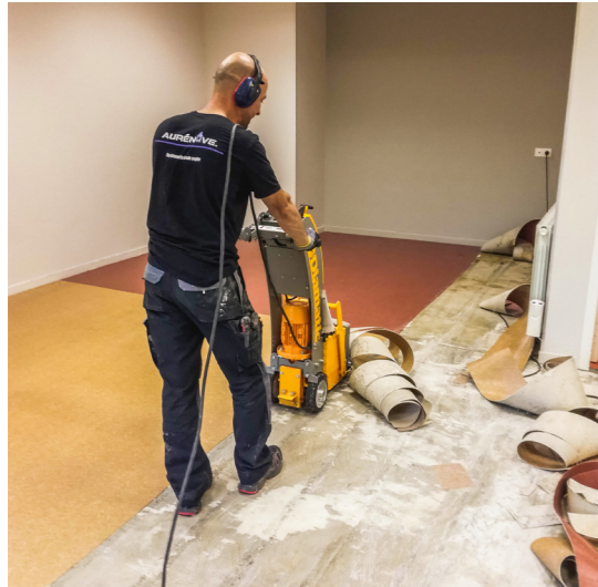
Retrait d'un sol existant !
