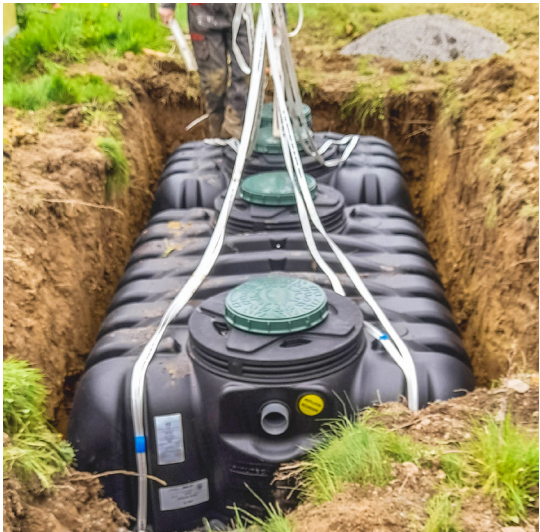
Pose d'un filtre compact !
