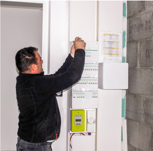
Pose d'un tableau électrique neuf!
