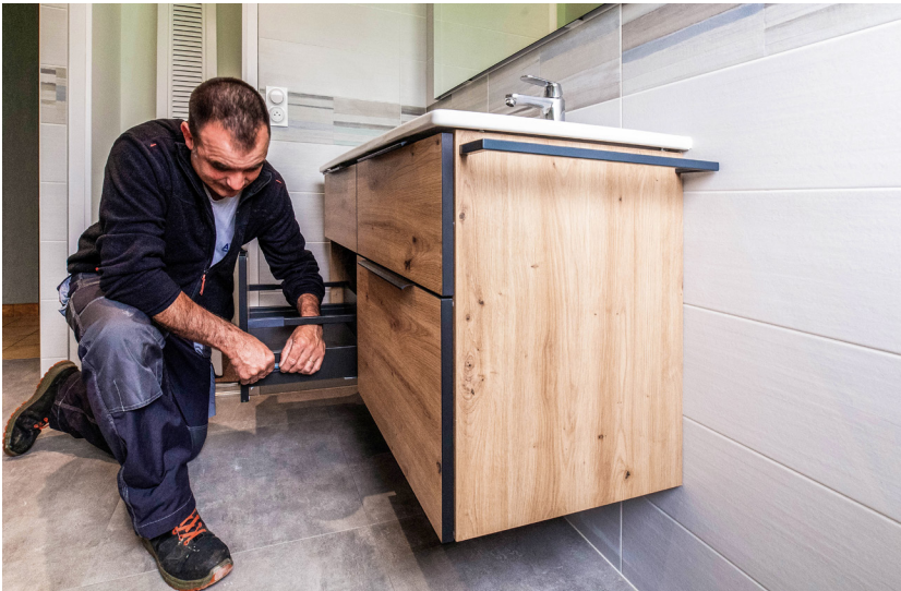
Rénovation, création de salle de bains !
