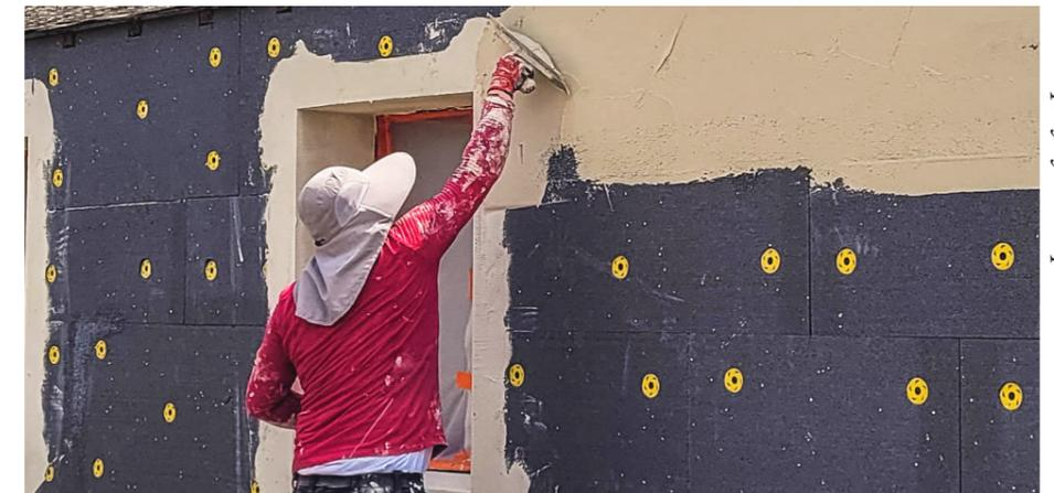
*Isolant polystyrène expansé !*
