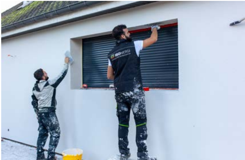
Réalisation de l’enduit de finition !
