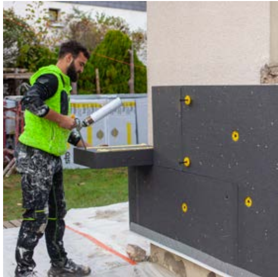
Pose des panneaux isolants !
