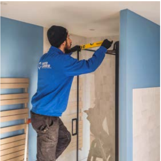
Travail de finition sur paroi de douche !
