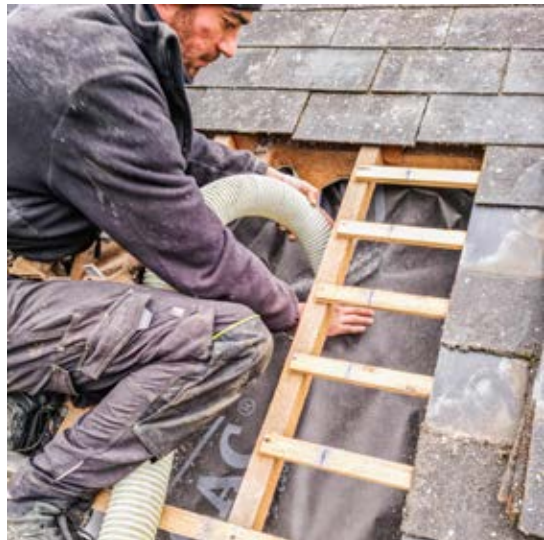
Insufflation de l'isolant !
