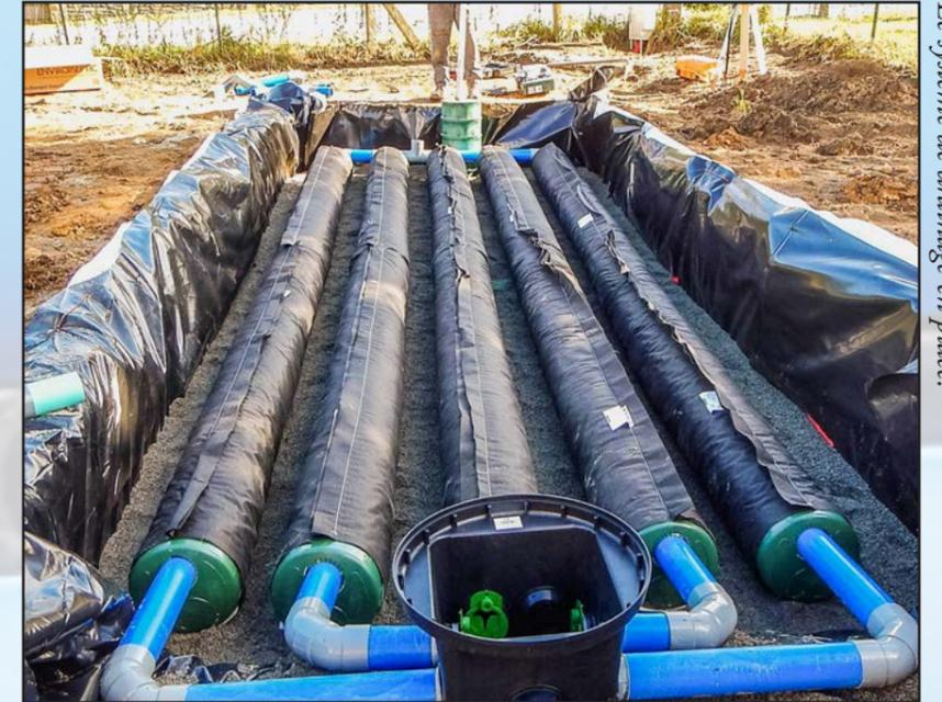
*Le système de drainage en place.*
