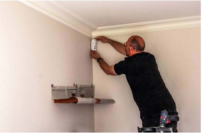
Installation des détecteurs de présence sans fils !
