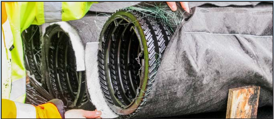
Les conduites de l'Enviro))Septic en détail.
