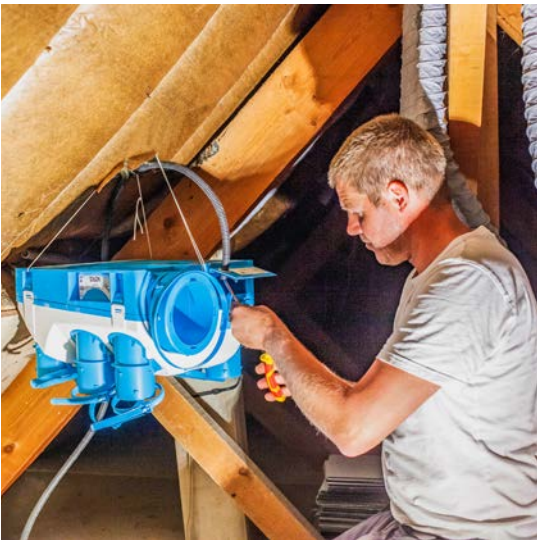
Akelec a également installé la VMC !
