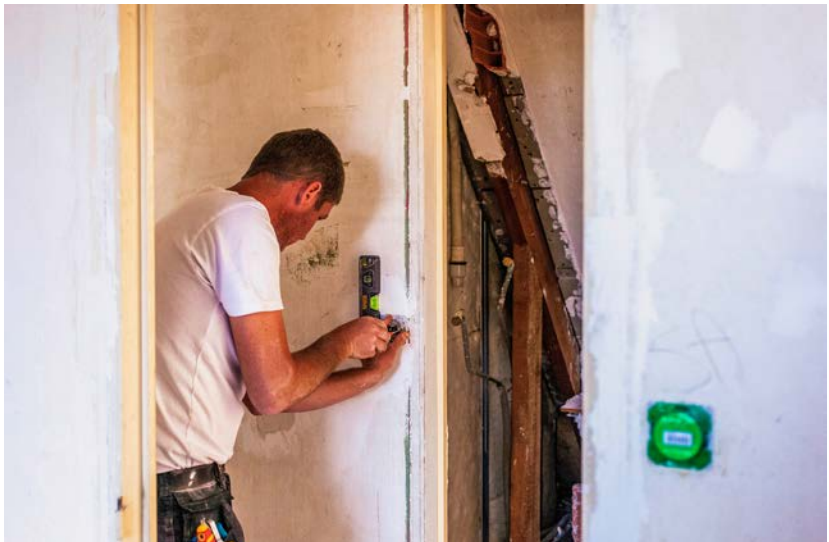
L'ensemble du réseau électrique a été remplacé !
