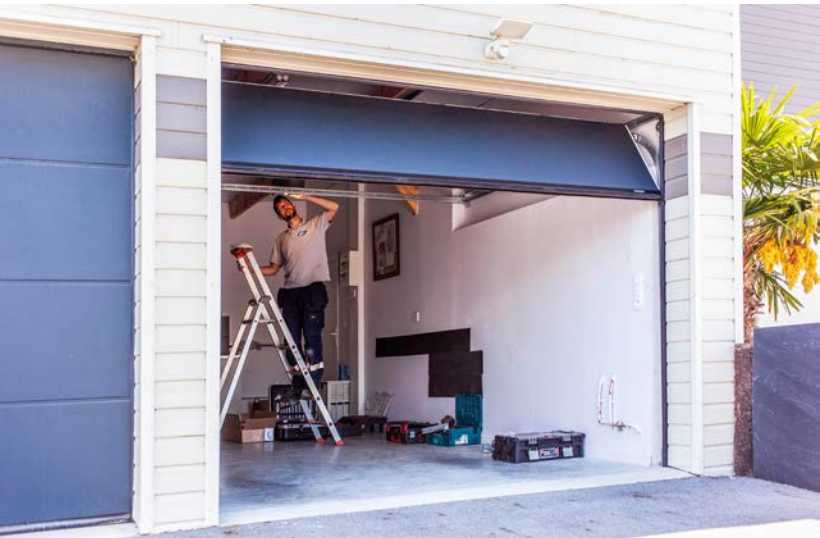
Réglage de la nouvelle porte de garage !
