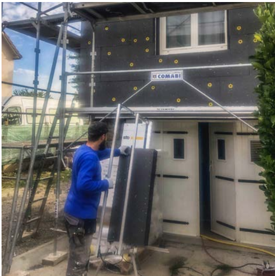
Pose de panneaux en PSE gris !
