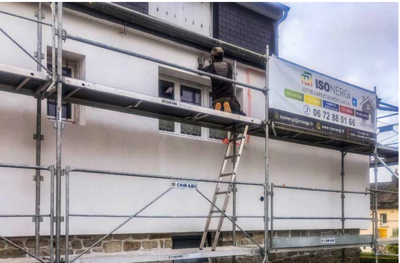
Application de l'enduit de finition !
