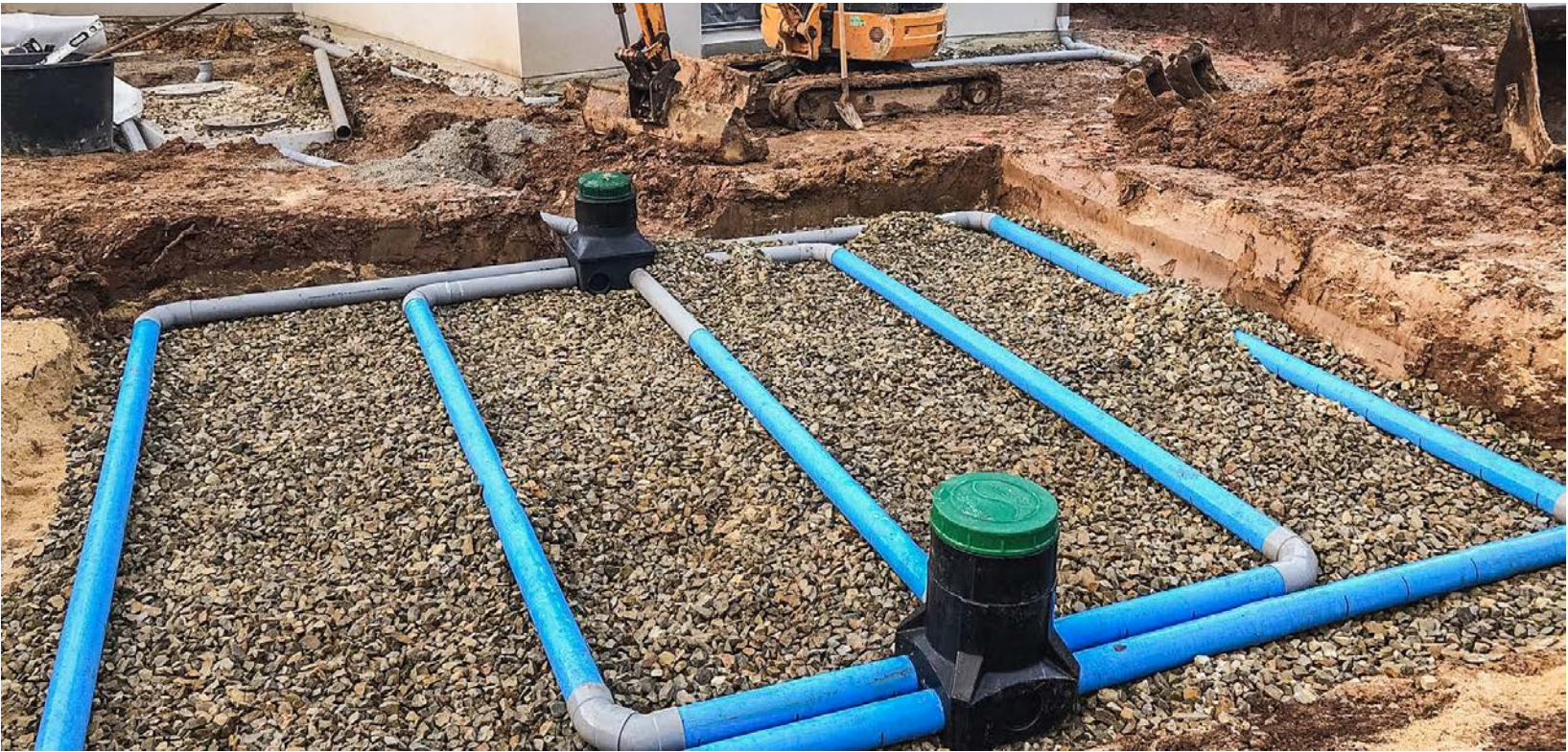
Installation d'un filtre à sable !
