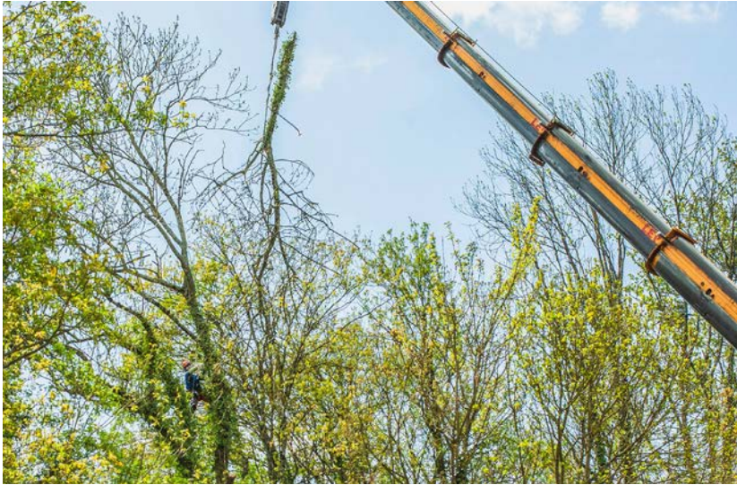
Un camion grue a été utilisé pour descendre les branches au sol !
