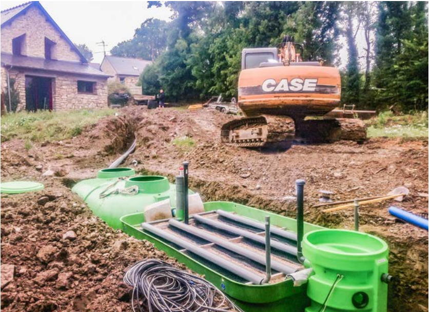
Mise en place d'une Zeoliteparco !
