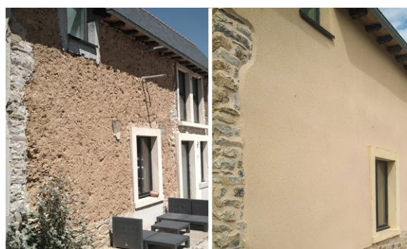
Rénovation extérieure en enduit chaux terre-chanvre !
