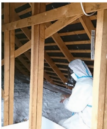
Isolation de combles perdus, aménageables et aménagées !
