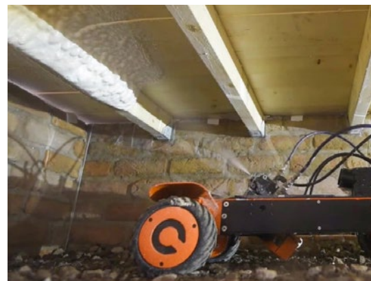
Isolation de vide sanitaire par robot !
