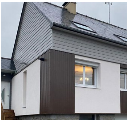
Isolation Thermique par l’Extérieur, finition mixte !
