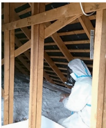
Isolation de combles perdus, aménageables et aménagées !
