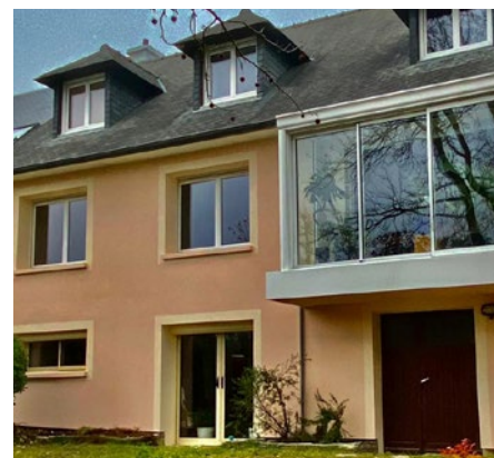
Remplacement de vos anciennes menuiseries !
