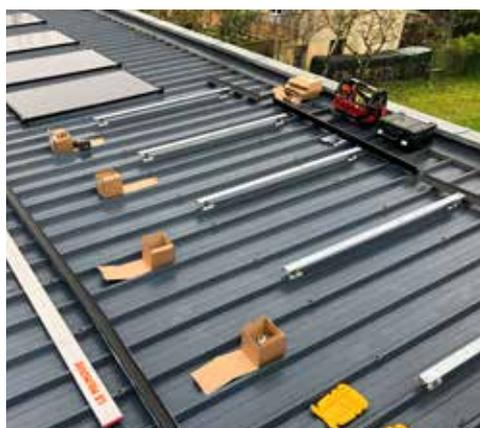
Rails de fixations des modules photovoltaïques
