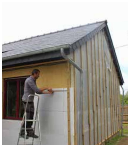
Pose des panneaux isolants
