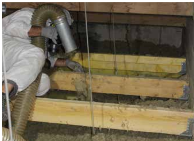
Isolation de combles perdus par soufflage de laine de roche
