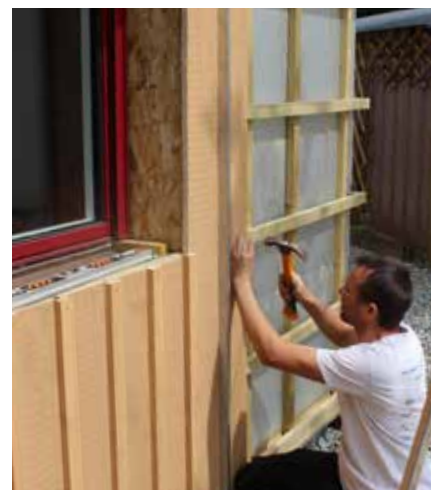
Pose du bardage en bois de châtaignier
