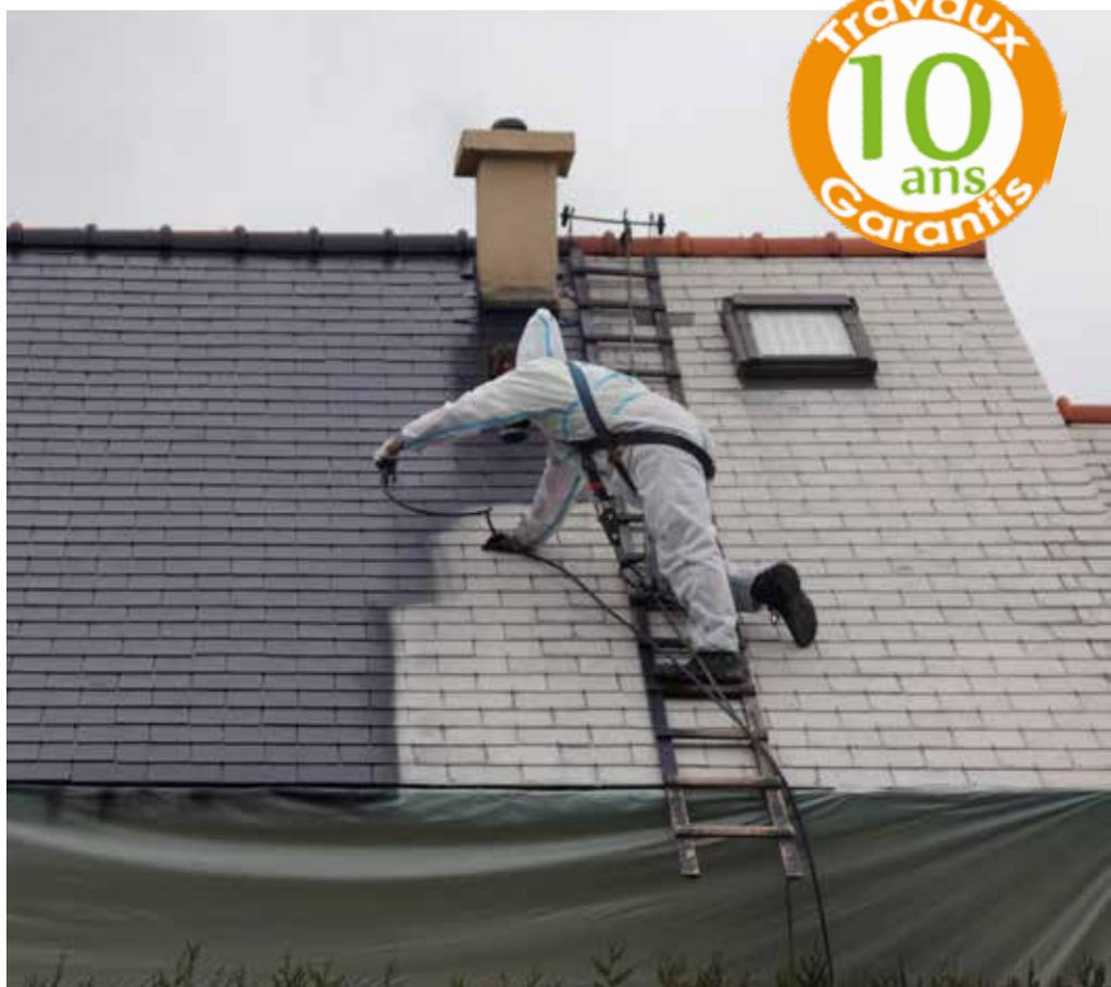
peut-être, que si les pollutions (mousses, lichens...) initialement éliminées ne réapparaissent pas et pour se faire, il convient d'assainir le support avant d'appliquer un anti-mousse, ça n'est qu'ensuite que l'imperméabilisation et la recoloration par résine hydrofuge colorée peut se réaliser, sous les yeux de
