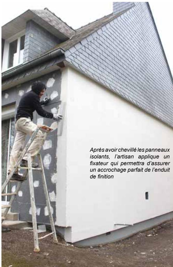
*Après avoir chevillé les panneaux isolants, l'artisan applique un fixateur qui permettra d'assurer un accrochage parfait de l'enduit de finition*
