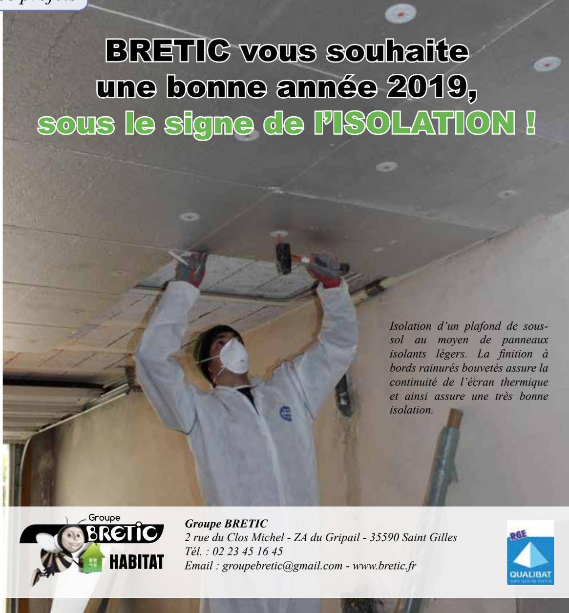
Isolation d'un plafond de sous-sol au moyen de panneaux isolants légers. La finition à bords rainurés bouvetés assure la continuité de l'écran thermique et ainsi assure une très bonne isolation.
