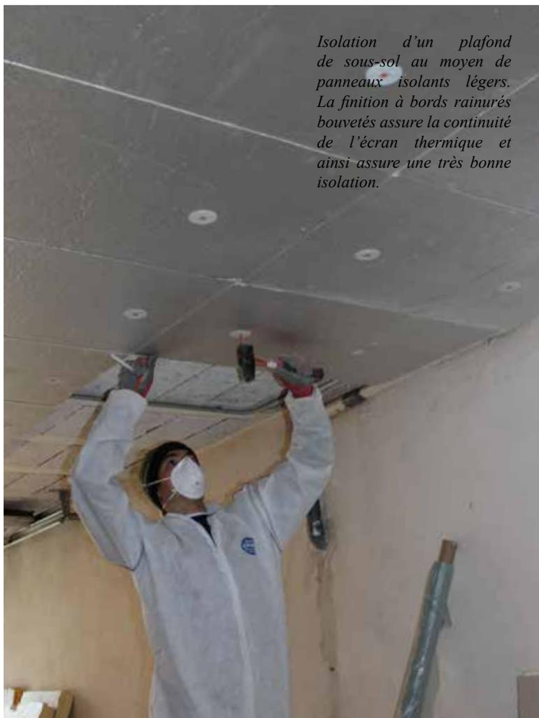
*Isolation d'un plafond de sous-sol au moyen de panneaux isolants légers. La finition à bords rainurés bouvetés assure la continuité de l'écran thermique et ainsi assure une très bonne isolation.*
