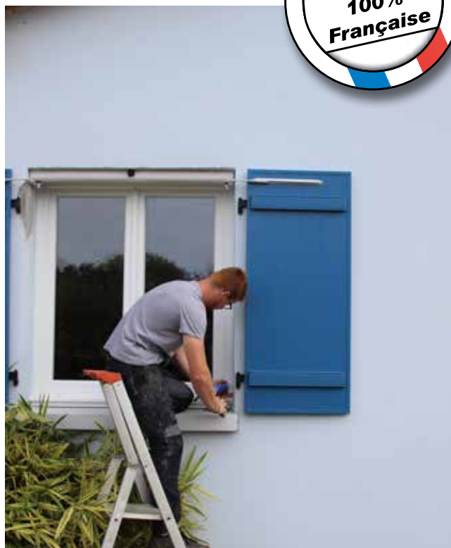
Remplacement d'une fenêtre 2 vantaux
