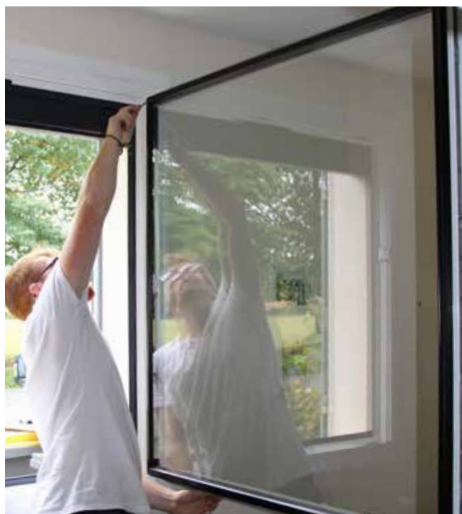
Remplacement d'une fenêtre 1 vantail
