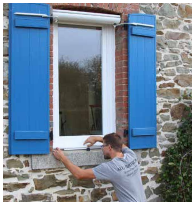
Travail de finition après pose
