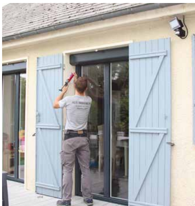
Remplacement d'une porte-fenêtre
