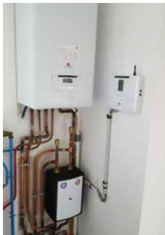
Remplacement de chaudière
