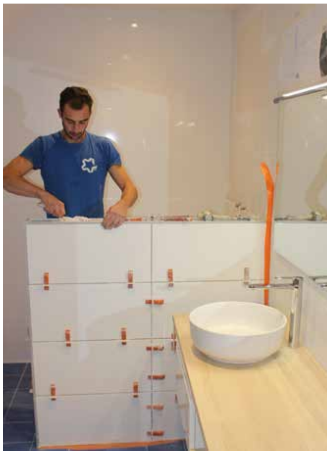
Préparation d'une paroi de douche
