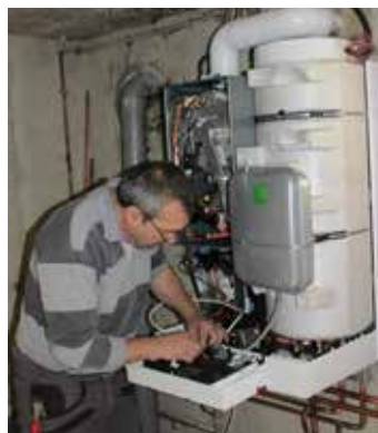
Chaudière à condensation
