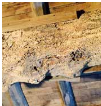
Poutre dévastée par les insectes
