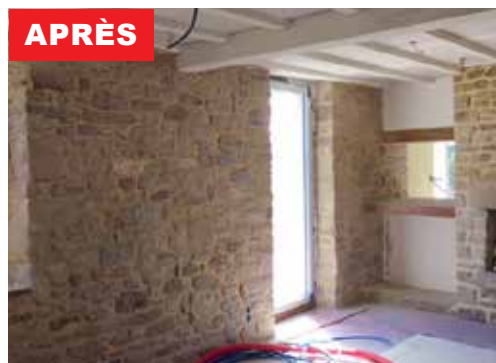
Exemple de sablage de mur en pierre intérieur
