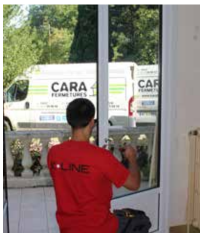
Remplacement d'une porte-fenêtre
