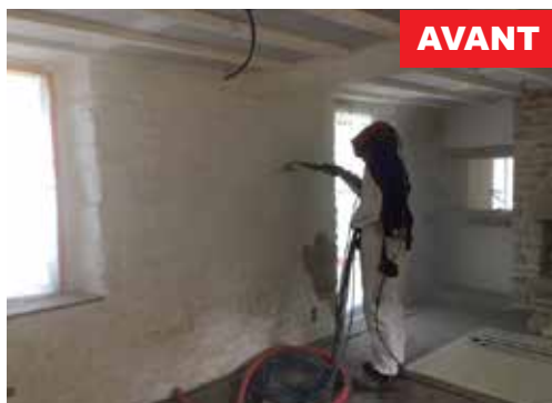
Exemple de sablage de mur en pierre intérieur
