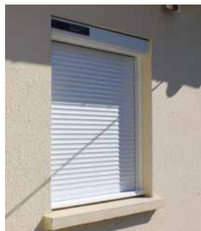
APRES : Pose d'un volet roulant solaire
