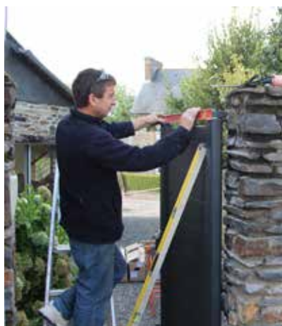
Pose d'un portillon ALU
