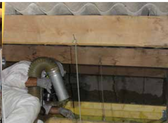
Isolation combles par soufflage
