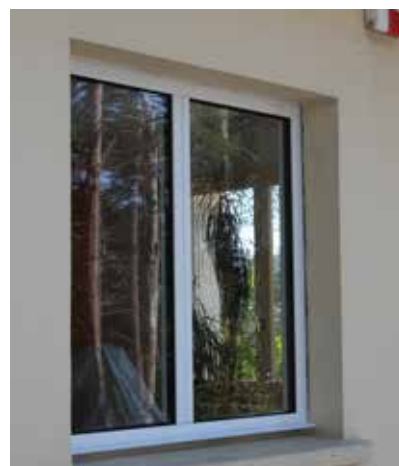
PENDANT : Remplacement de la fenêtre
