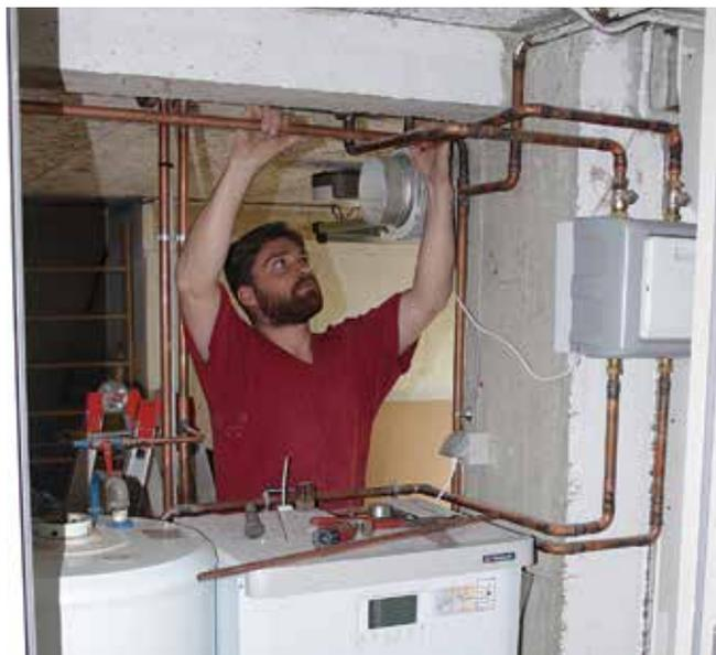
*Travaux d'adaptation hydraulique au niveau de la chaudière suite à l'ajout de radiateurs*
