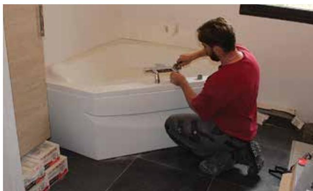
*Suppression d'une cloison et ajout d'une baignoire d'angle*
