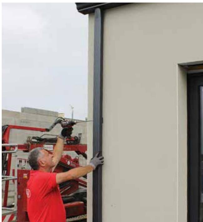
*Descente d'eau de pluie compatible avec les gouttières aluminium*
