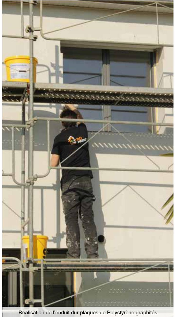
Réalisation de l'enduit dur plaques de Polystyrène graphités
