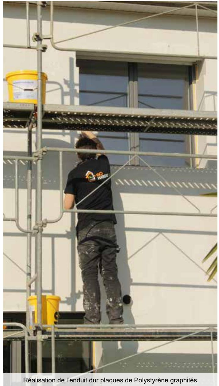
Réalisation de l'enduit dur plaques de Polystyrène graphités
