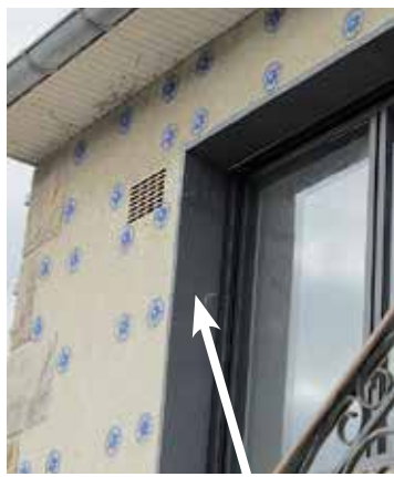
Isolation des contours de fenêtres
