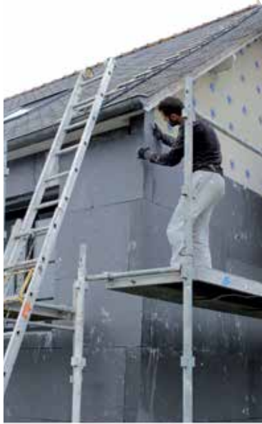
Isolation par panneaux isolant polystyrène graphité
