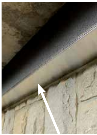
Isolation des soubassements
