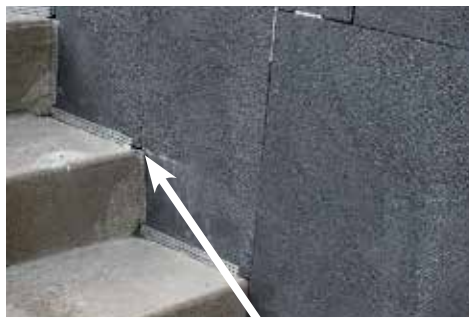
Isolation des murs sur-mesure
