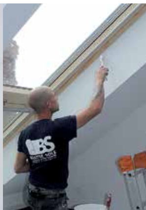
Rénovation de peinture
