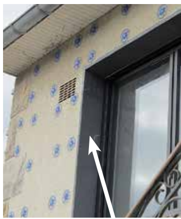
Isolation des contours de fenêtres
