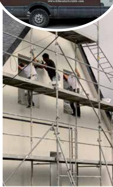
Application de l'enduit de finition sur isolant graphité
