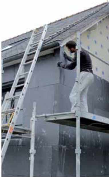
Isolation par panneaux isolant polystyrène graphité
