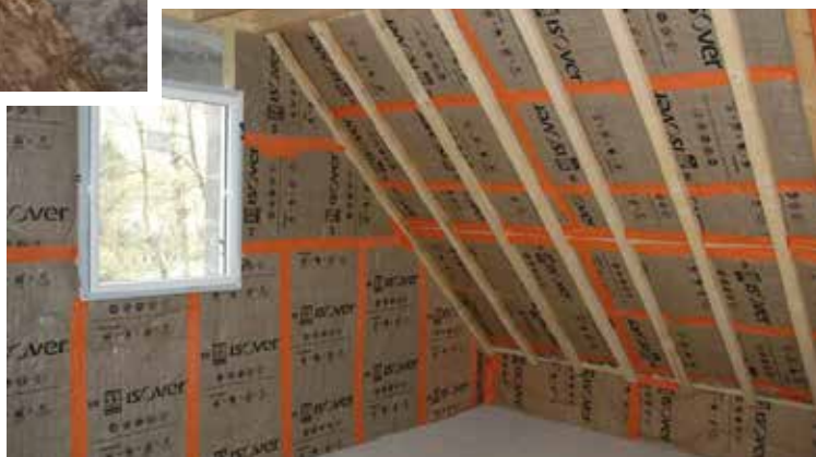
Isolation de combles à aménager
