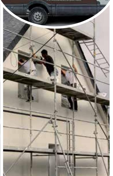
Application de l'enduit de finition sur isolant graphité
