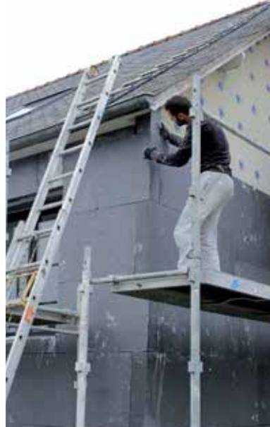
Isolation par panneaux isolant polystyrène graphité
