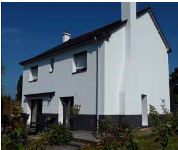
Isolation thermique extérieure avec un mix enduit bardage
