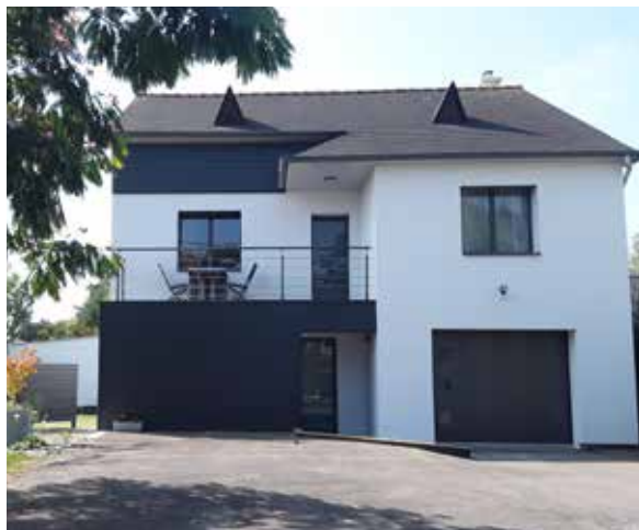
Isolation thermique extérieure avec un mix enduit bardage
