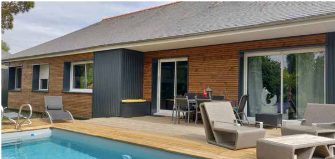
Isolation thermique extérieure avec un mix acier bois
