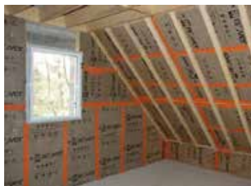
Isolation de murs et sous rampants
