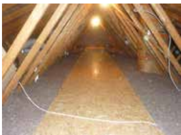
Isolation de combles par soufflage
