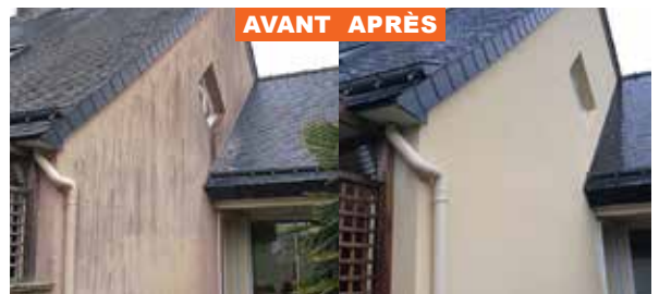
Rénovation de façades
