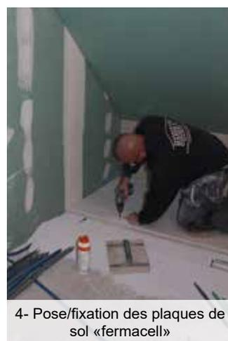
4- Pose/fixation des plaques de sol «fermacell»
