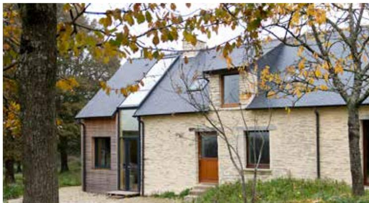
**Rénovation extérieure et extension bois, réalisées par TEN ARCHITECTEURS** : Démolitions intérieures, plancher bois et dalle béton, création d'ouvertures et/ou remplacement des menuiseries par des modèles bois, extension en ossature bois, isolation.
